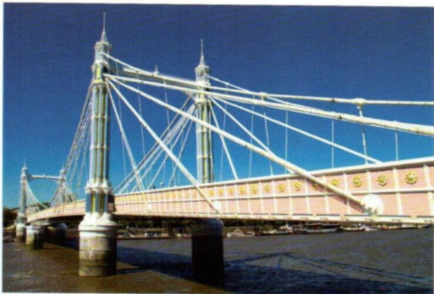
Il ponte è stato aperto nel 1873, le sue torri di ferro sono alte ventun metri e poggiano su dei cilindri di ghisa riempiti di cemento, con delle rigide fasce metalliche che lo tengono fermo.
