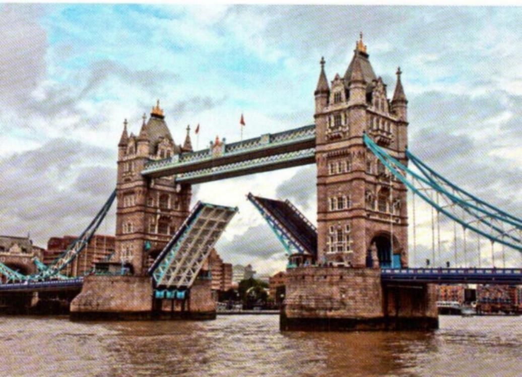
Il vecchio ponte, progettato da Horace Jones e da John Barry, aveva una bascula molto sofisticata a energia idraulica. Le fondamenta erano solide e le colonne dei moli ben assicurate. Oggi il ponte si apre circa mille volte all'anno e i visitatori possono arrampicarsi lungo la torre. Sulla riva nord, dietro a un cancello chiuso, ci sono dei gradini che scendono al Dead Man's Hole, dove venivano raccolti i corpi degli annegati.
